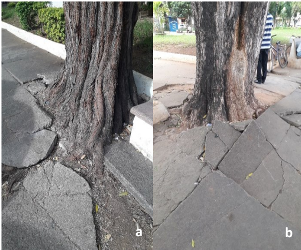
Figura 7. a e b: Danos causados por raízes das espécies algaroba [ Prosopis juliflora (Sw.) DC.] e oiti [ Licania tomentosa (Benth.) Fritsch], respectivamente, na praça central em Almenara (MG). Fonte: Acervo de fotos dos autores (2018).
